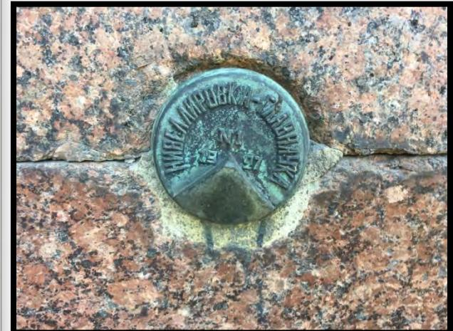
Стенная марка, предназначенная для наблюдений за
