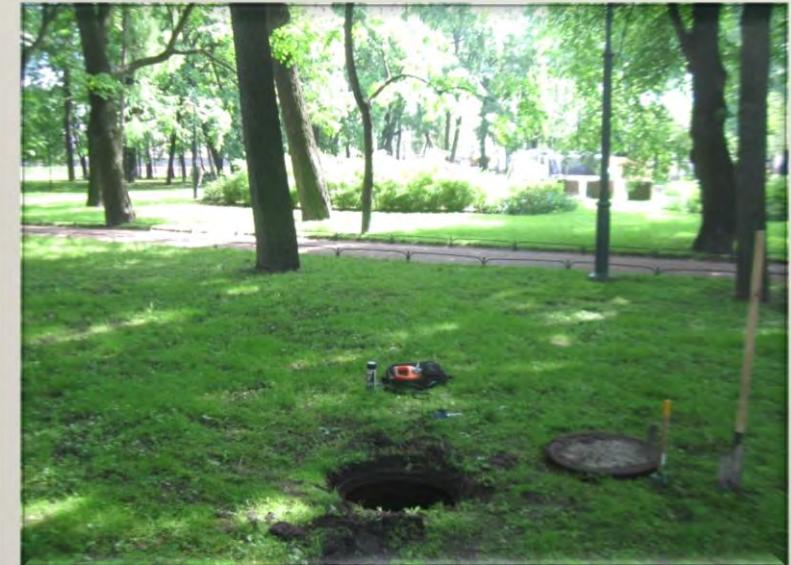
Глубинный репер - нивелирный репер специальной конструкции (основание которого устанавливается на плотные, динамически устойчивые грунты), служащий высотной геодезической основой для выполнения геодезических наблюдений за деформациями зданий, сооружений и земной поверхности.
